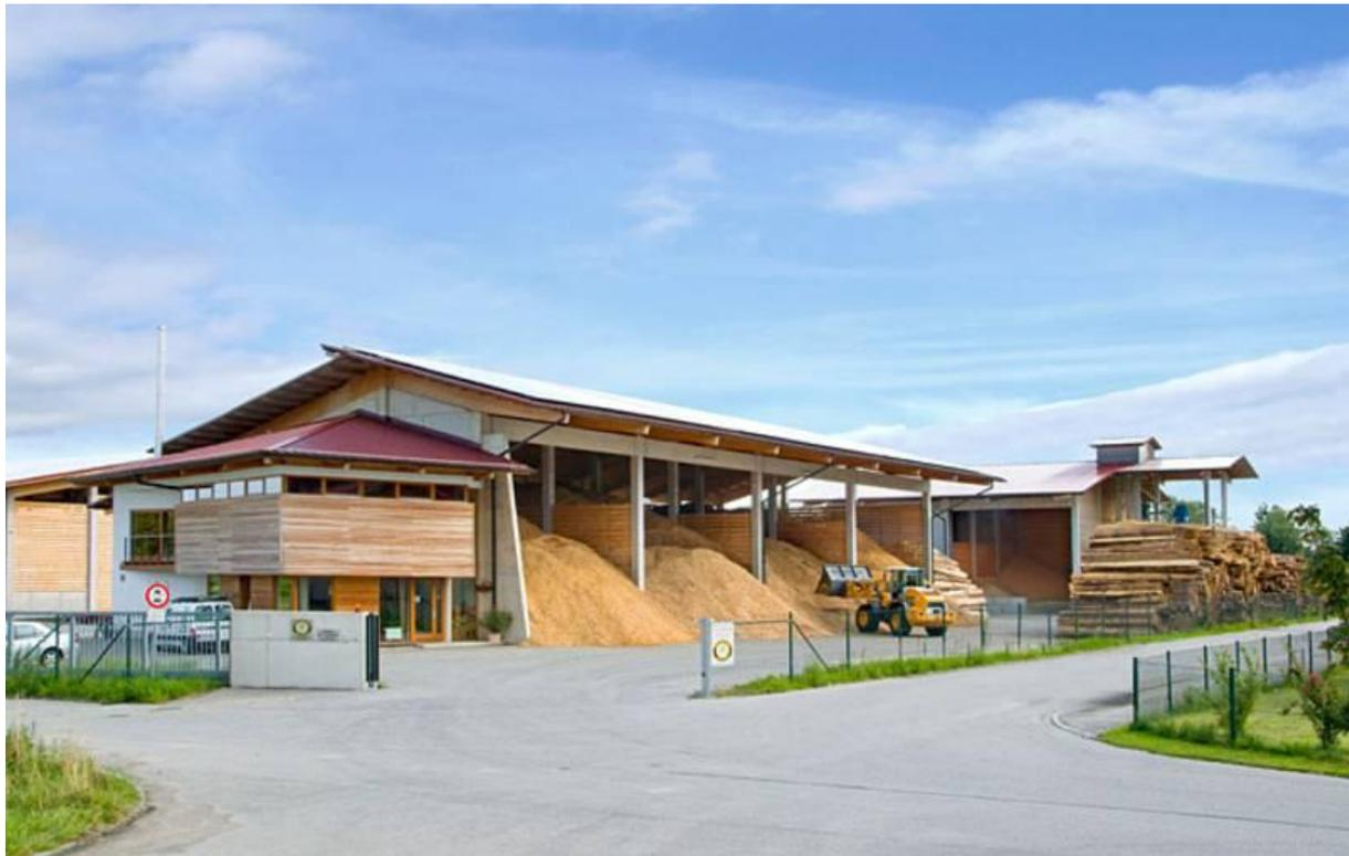
Abbildung 3: Der Biomassehof Achental in Grassau im Chiemgau, mit Bürogebäude (linke Ecke), Lager- und Trocknungshallen für HHS (Mitte) und Lagerhallen für Pellets (rechts).
