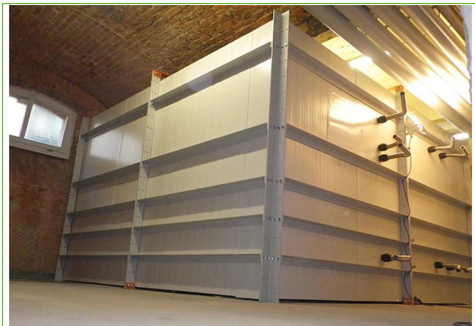
Abbildung 15: Modular aufgebauter Rechteckspeicher (Quelle: FSAVE GmbH)
