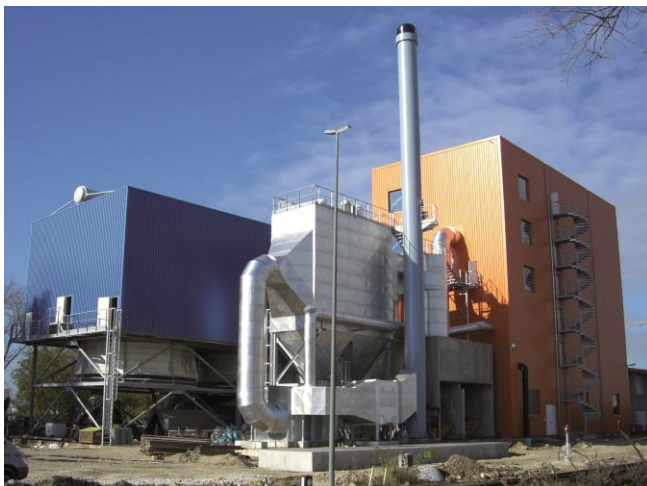
Heizkraftwerk Ingolstadt ©Seeger Engineering AG
