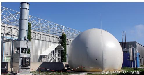
Biogutvergärungsanlage nach dem Boxenverfahren
