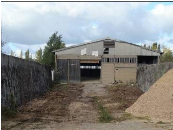
Abbildung 9 Lagerhalle Energiepark Glossen
