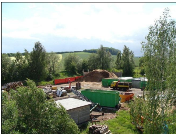
Abbildung 5 Lagerflächen Biomassehof Oberlausitz
